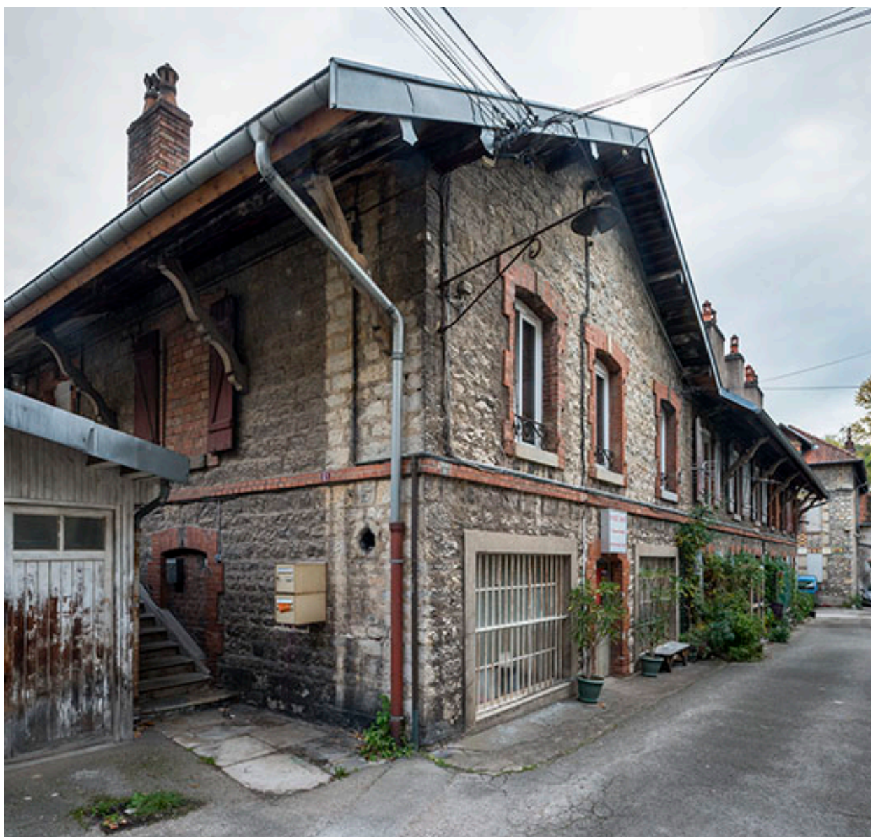
Pignon et façade sud de la distillerie.
