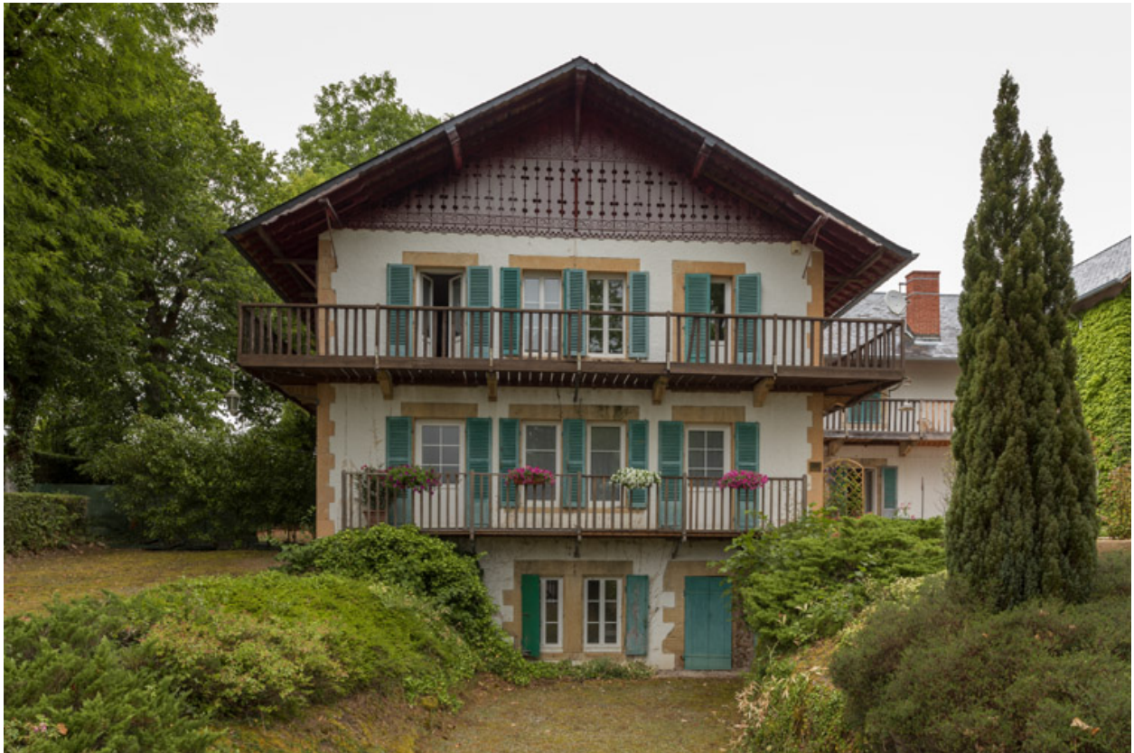
Façade du corps principal, vue de face.
