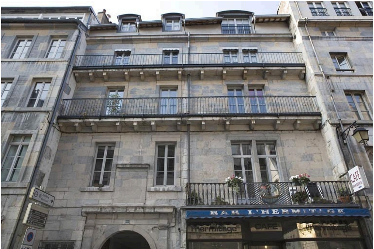
Partie centrale de la façade sur rue, de face.
