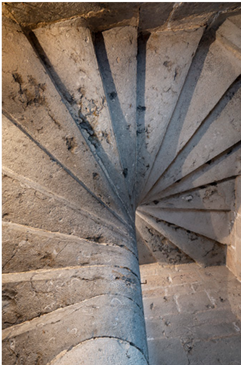
Escalier en vis. Vue en contre-plongée.
