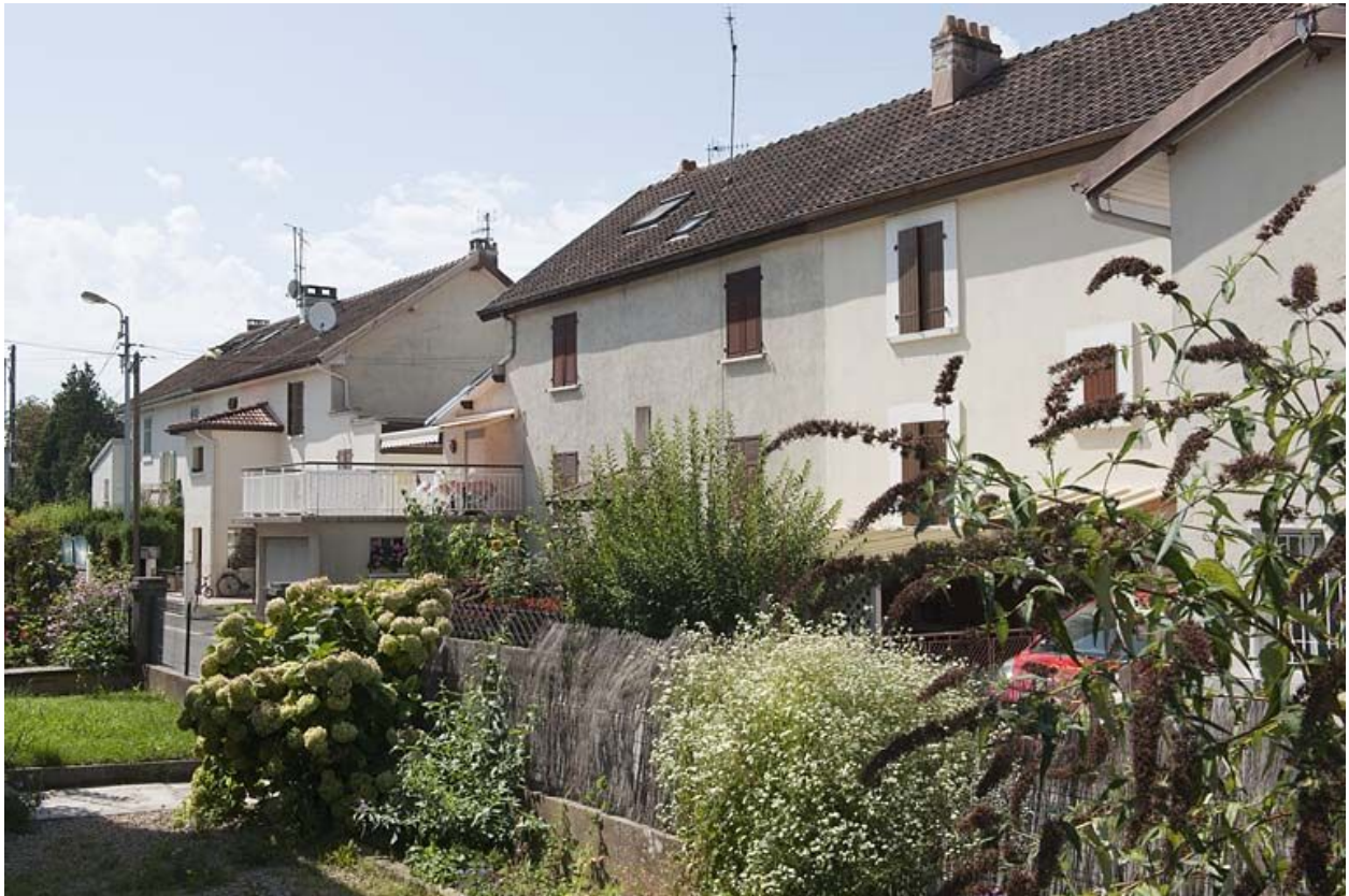
Façades postérieures vues de trois quarts.
