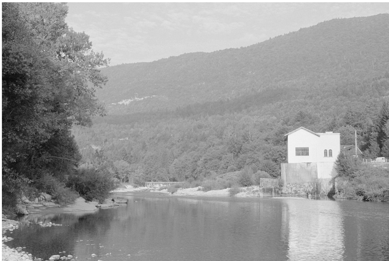
Vue d'ensemble, depuis l'aval.
