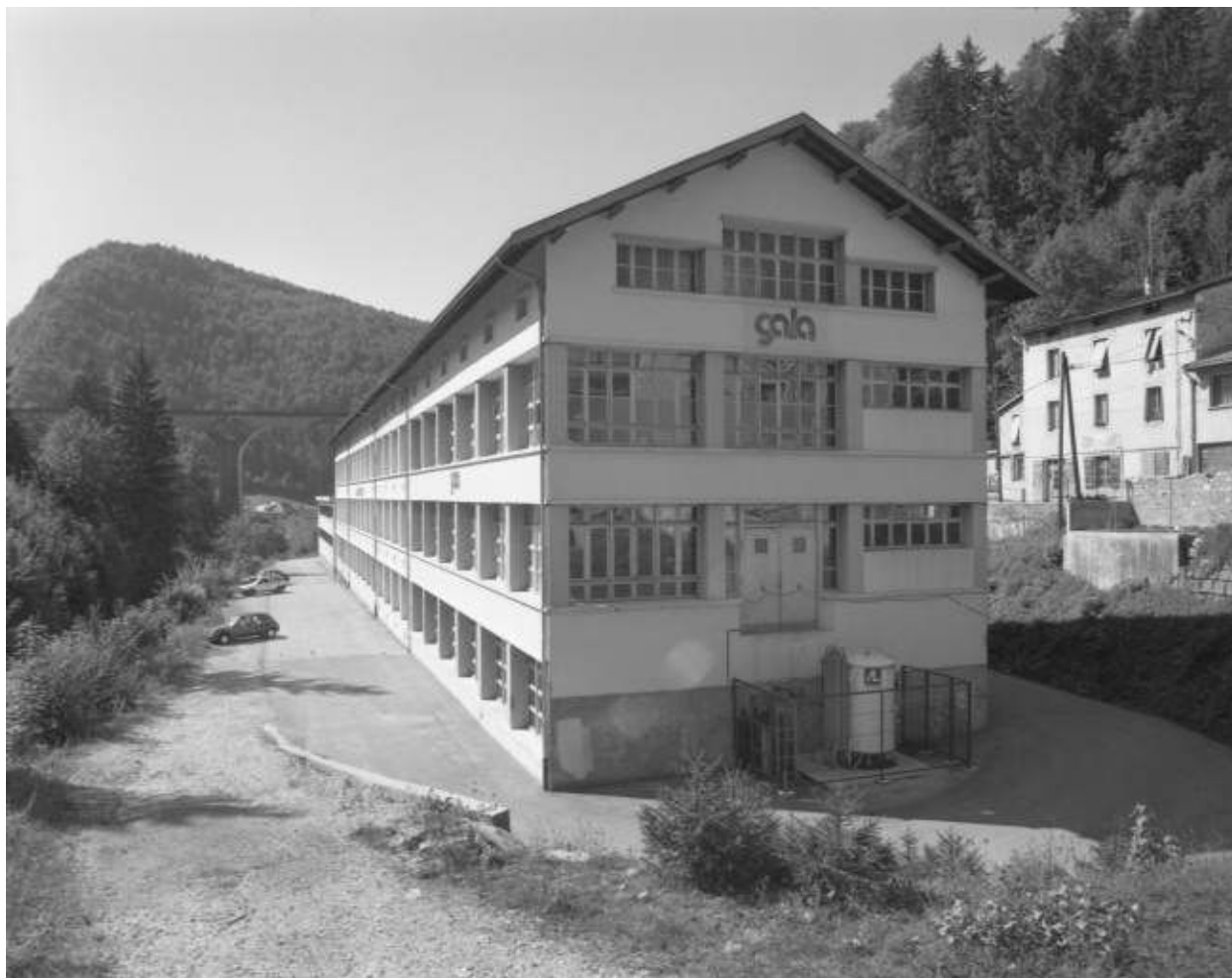
Façades postérieure et latérale gauche.
