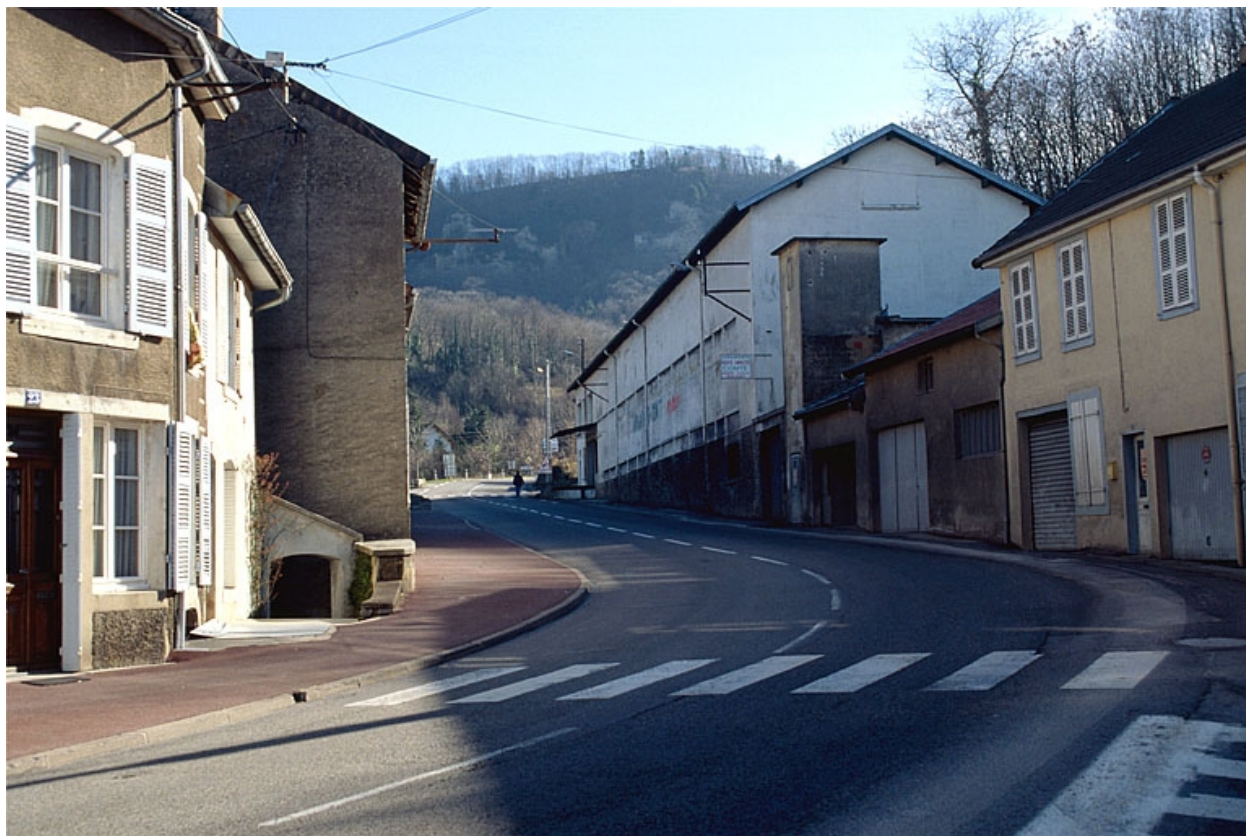
L'atelier de fabrication depuis l'ouest.
