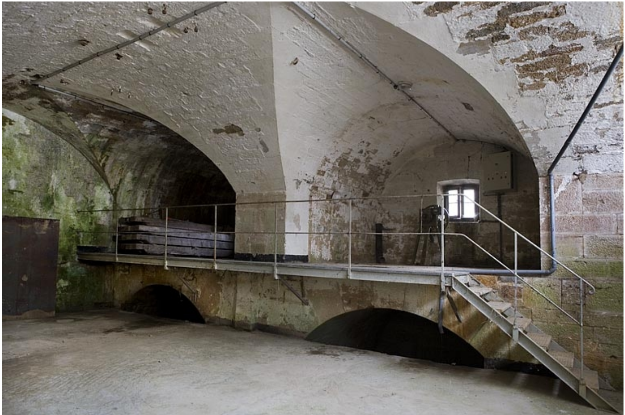
Intérieur de la casemate amont : coursiers voûtés.
