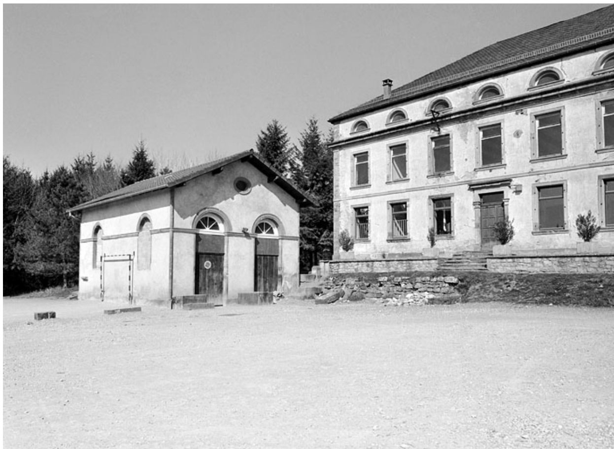
Salle des machines.
