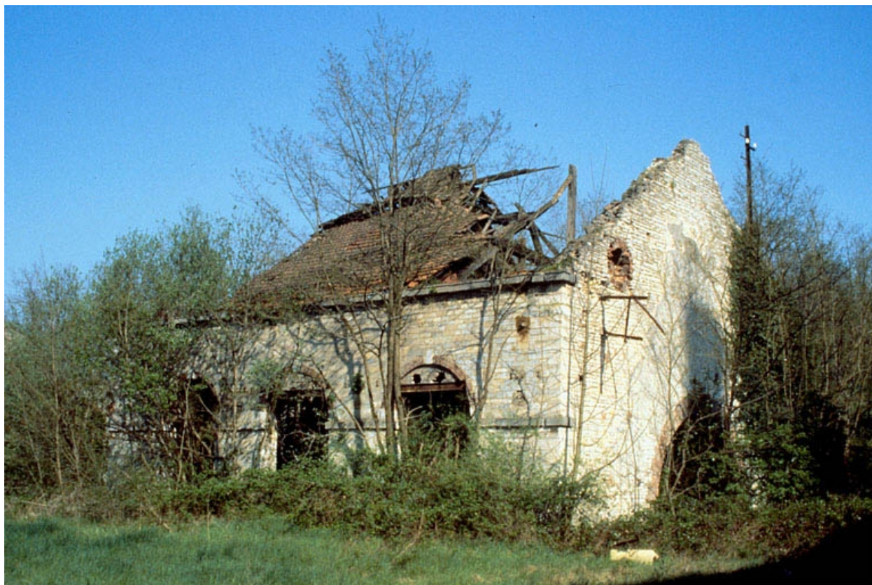
Forge Neuve. La fonderie vue de trois quarts droit.
