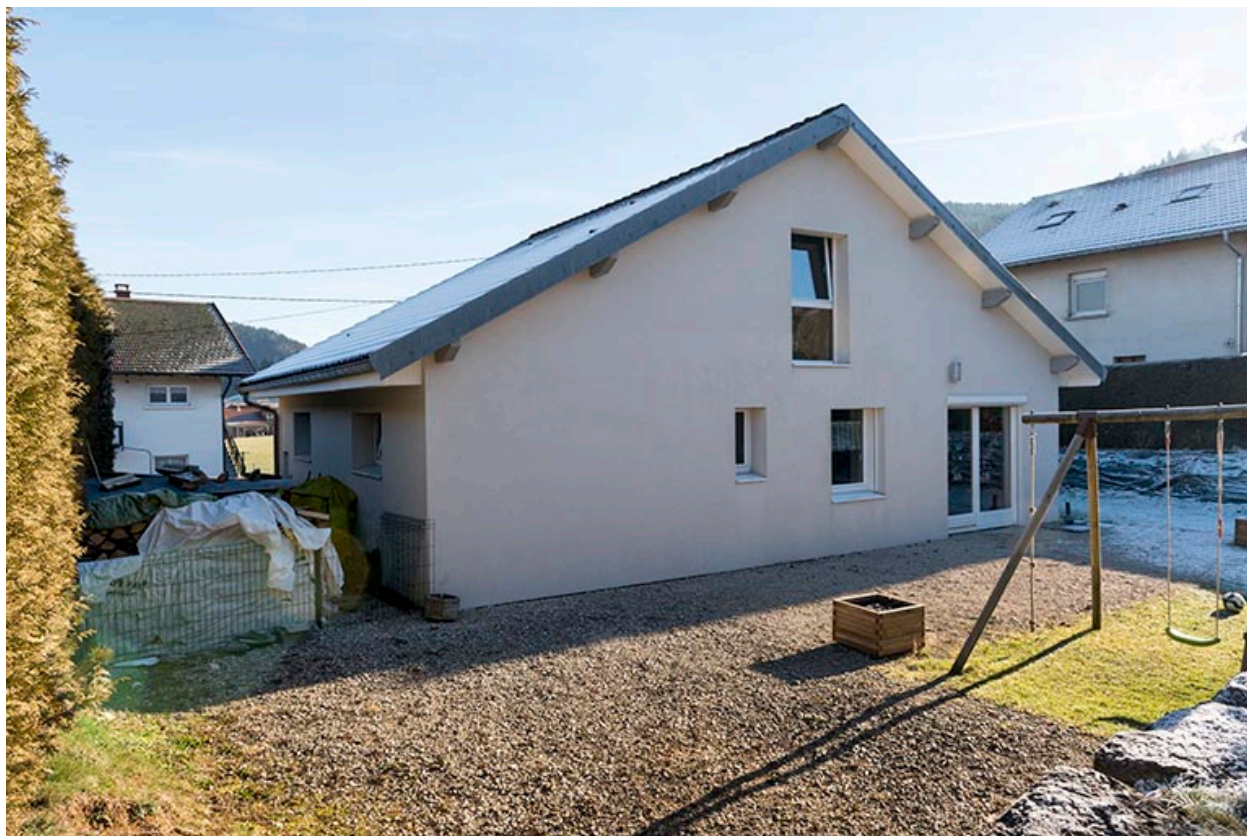
Façades postérieure et latérale droite.
