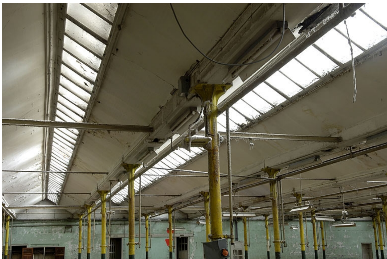
Salle de tissage. Détail des sheds.
