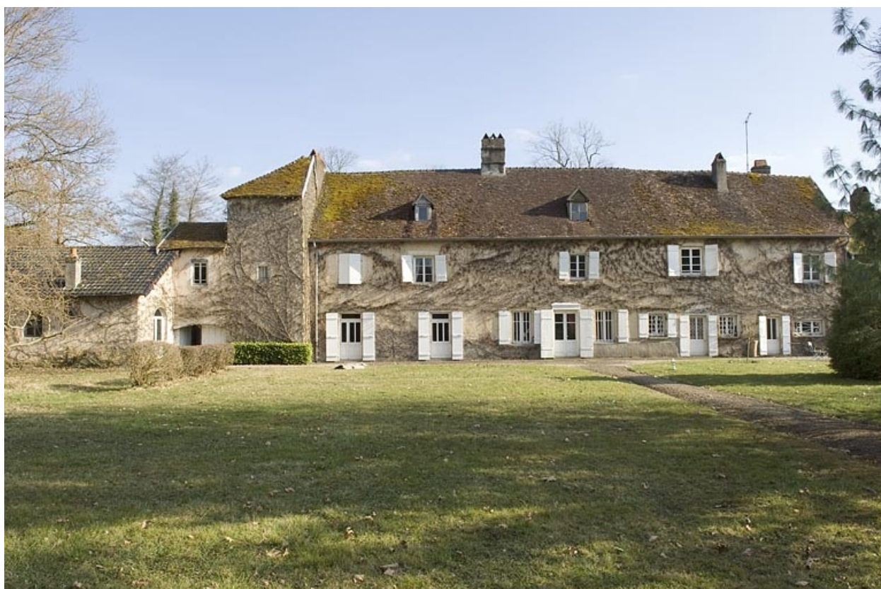
Façade postérieure du logis ouest.
