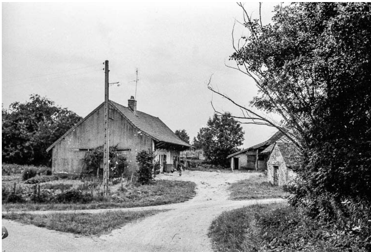
Ferme cadastrée 1969 AC 183 : vue d'ensemble.
