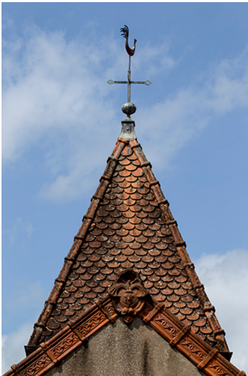
Campanile avec son toit en pavillon.
