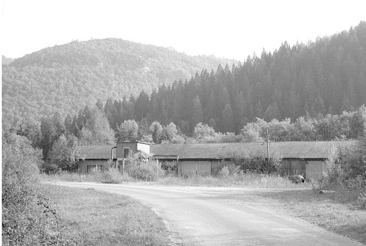
Façade côté route.
