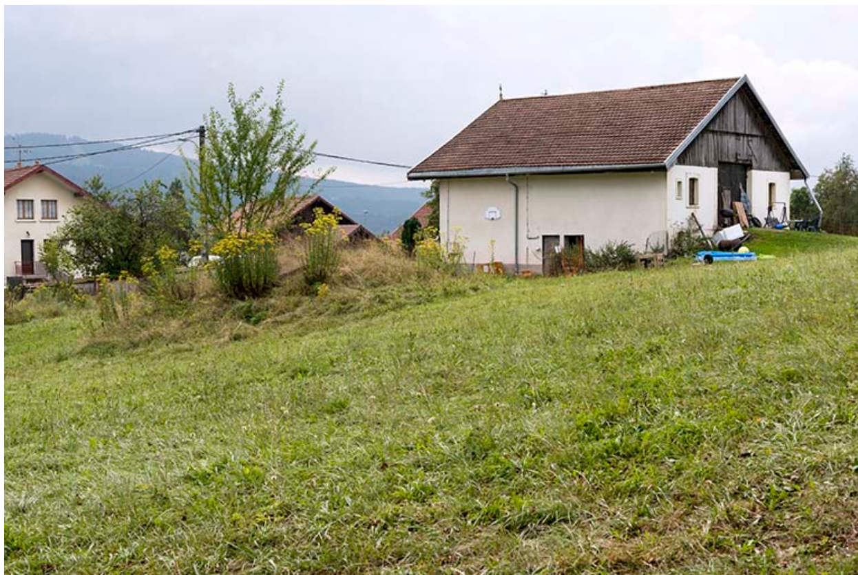
Façades postérieure et latérale droite.
