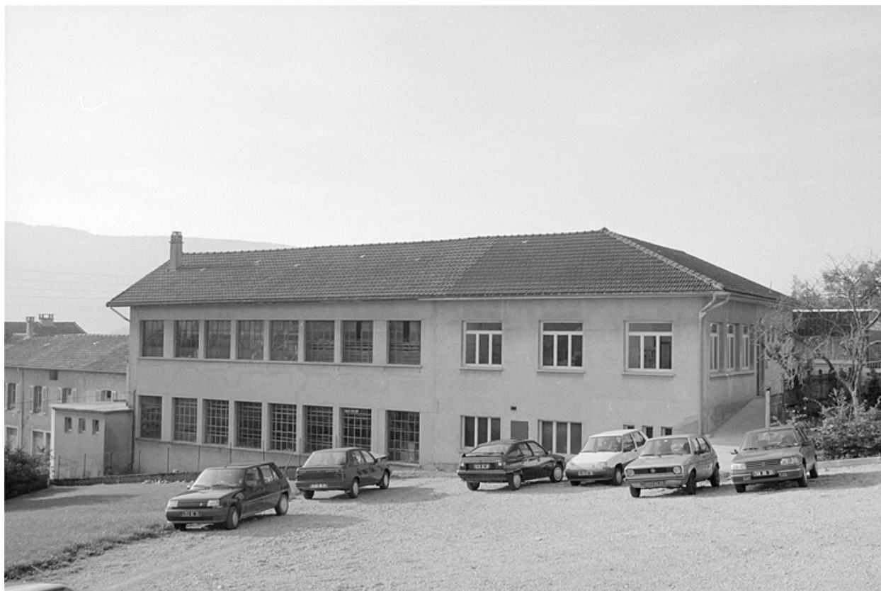
Atelier de fabrication (H), vu du nord-ouest.
