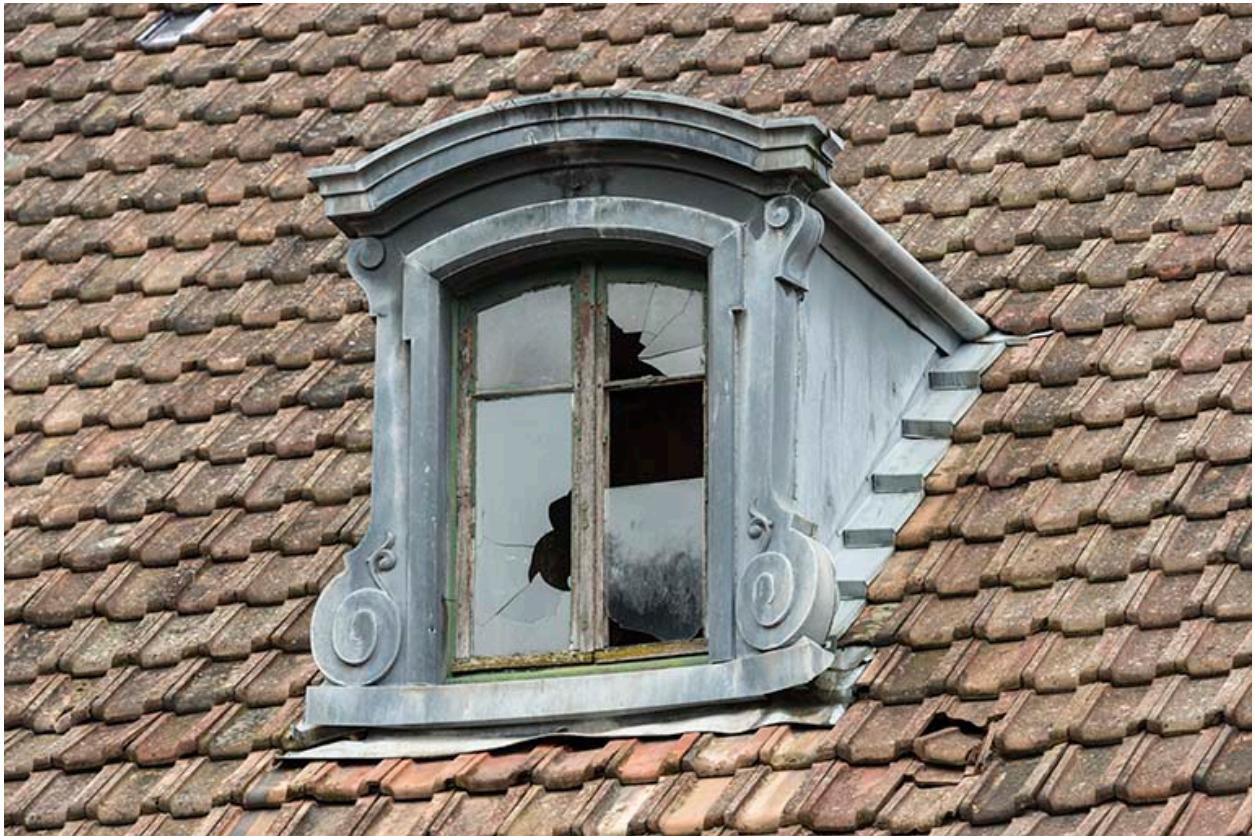
Etat en 2016. Usine A : lucarne des bureaux.
