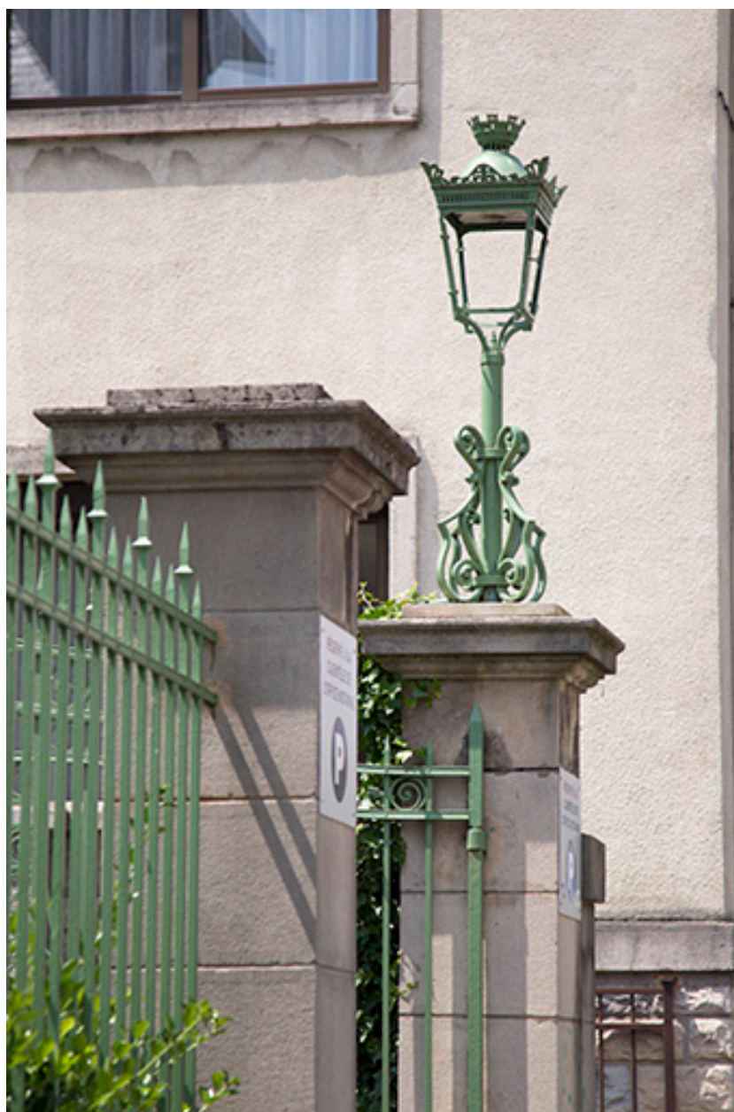
Portail : piliers, grille et luminaire.
