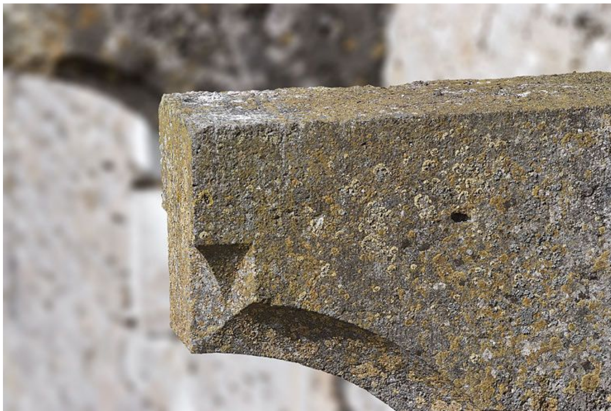
Un des corbeaux soutenant le chemin de ronde.
