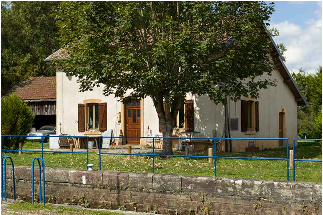
La maison d'éclusier, écluse n°39.
