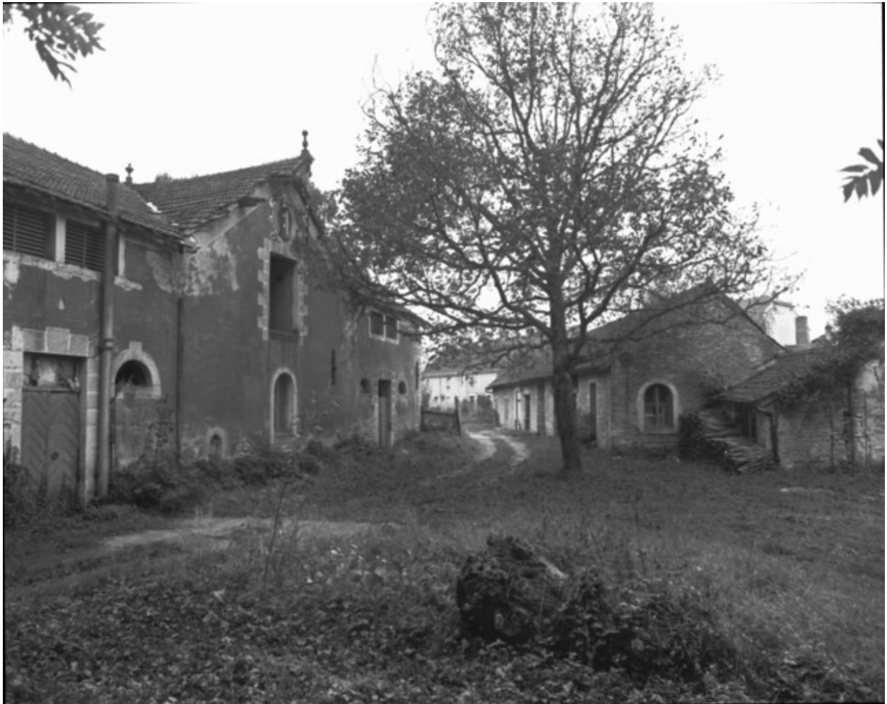
Ecurie et logement ouvrier depuis l'est en 1989.
