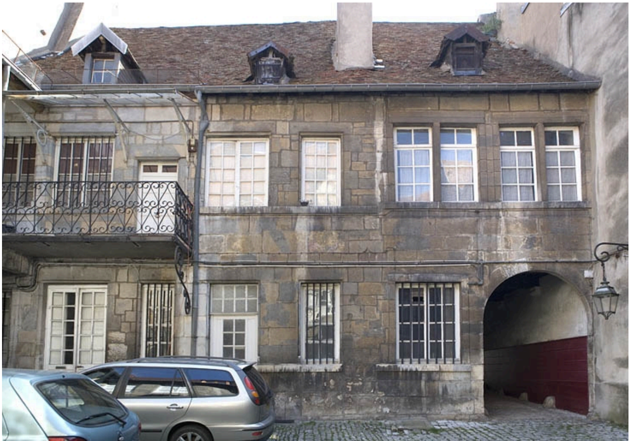
Vue d'ensemble de la façade postérieure du logis sur rue.
