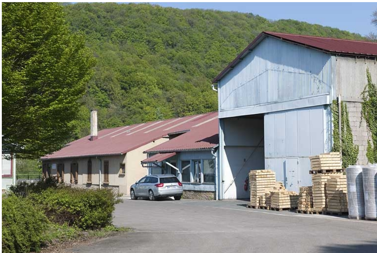
Magasins industriels à l'entrée du site.
