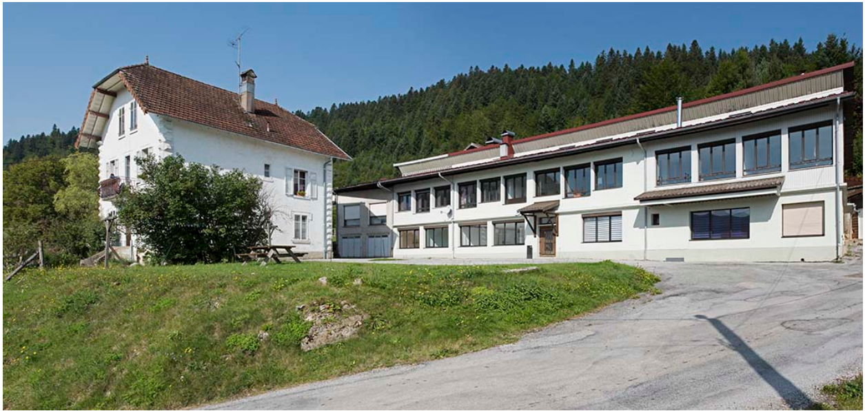
Maison et usine, depuis le sud-est.
