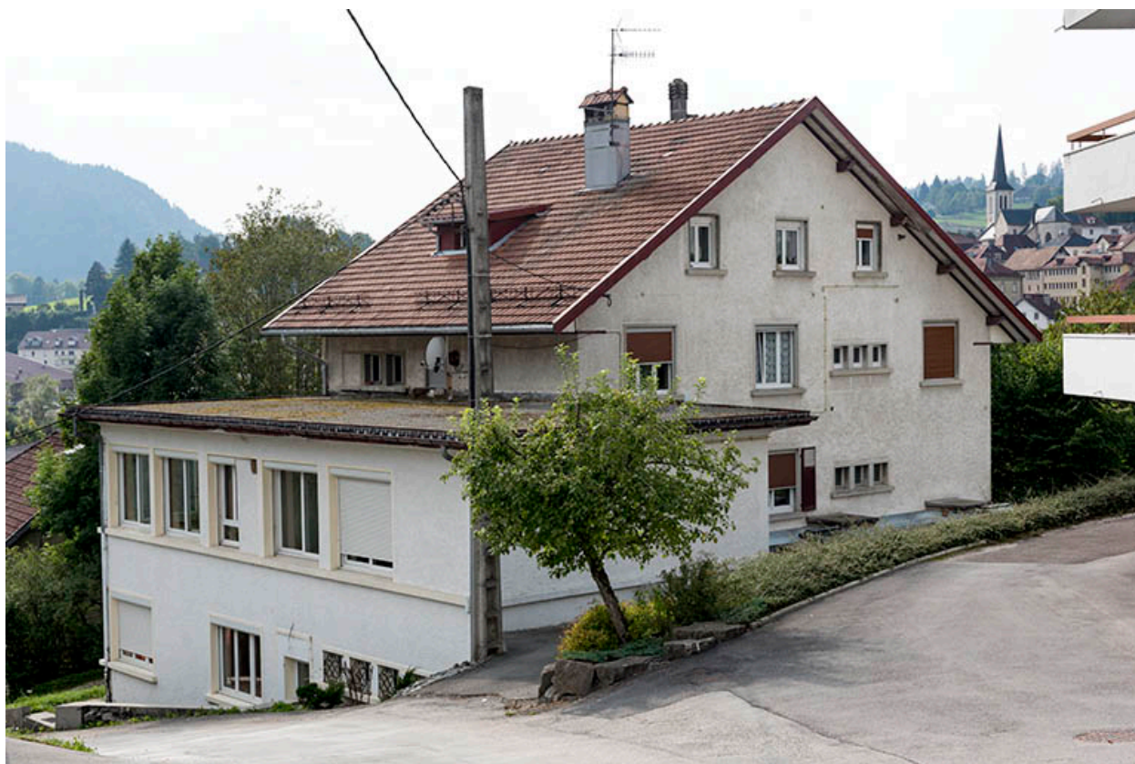
Façades postérieure et latérale droite.
