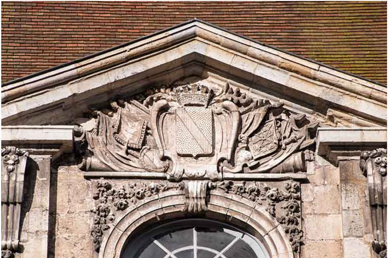
Détail du fronton de la façade est.
