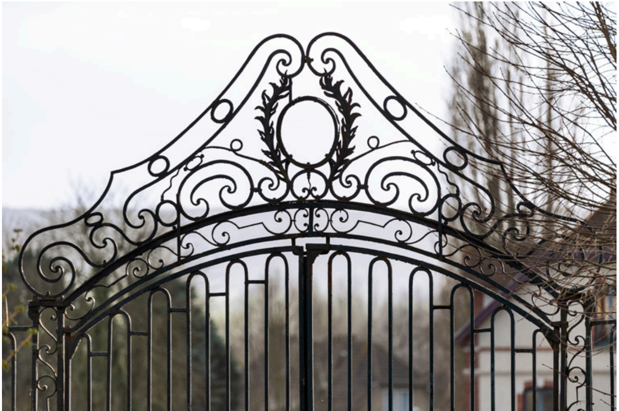
Couronnement de la grille, vu du parc.
