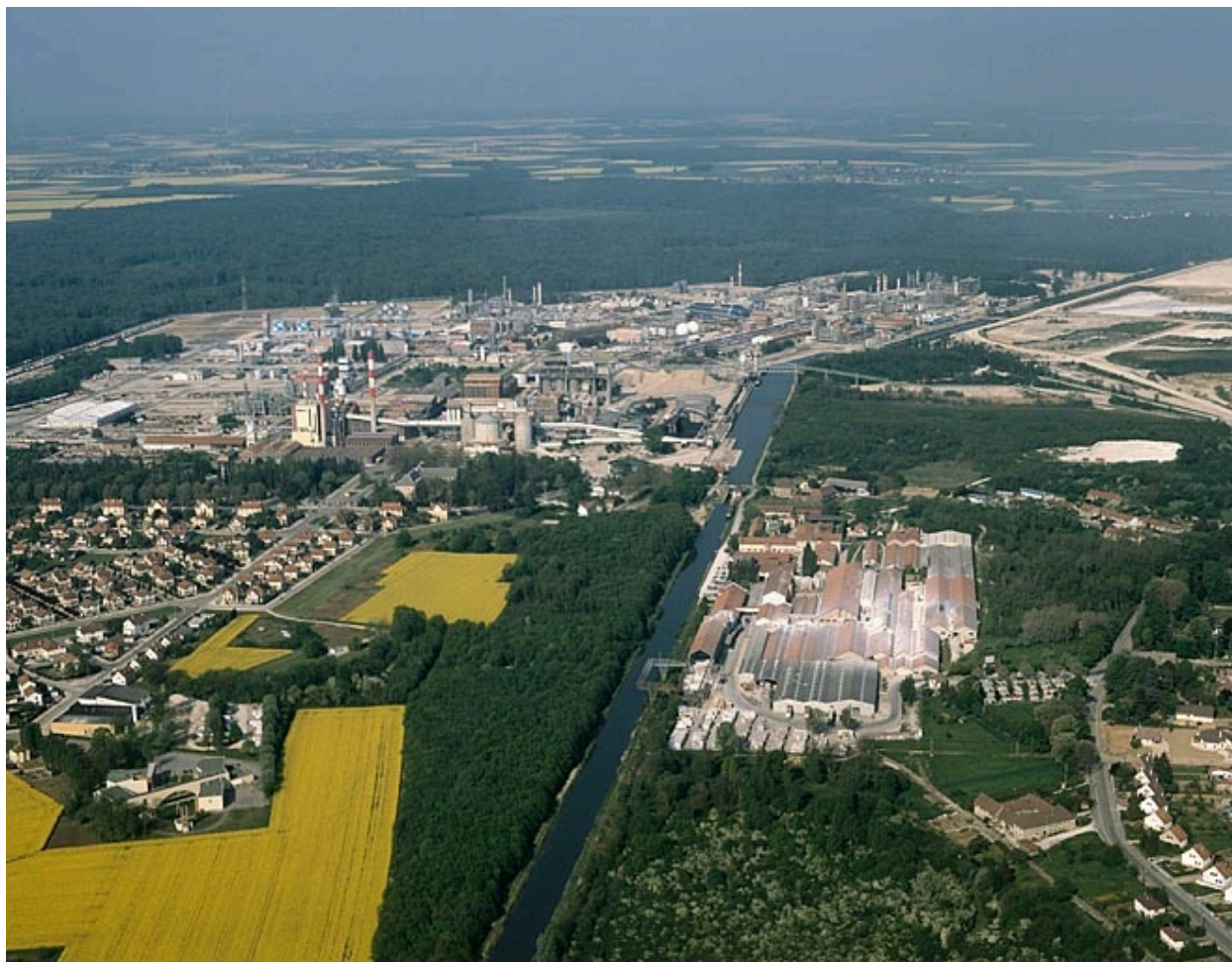
Abergement-la-Ronce : usine de produits chimiques de la société Solvay et Cie.
