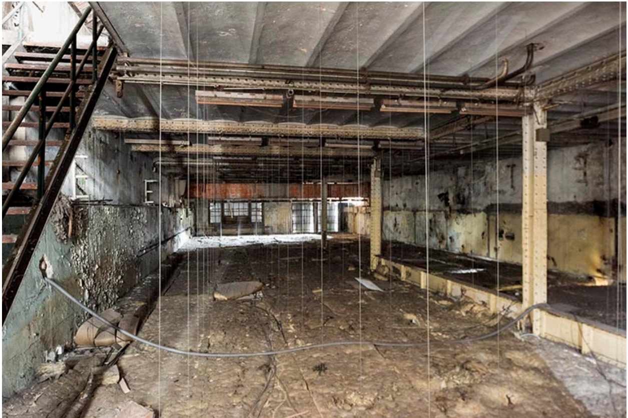
Etat en 2016. Usine A : rez-de-chaussée de la chaufferie.
