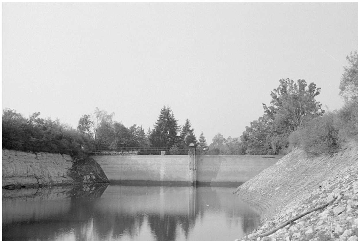
Barrage et bassin de retenue.
