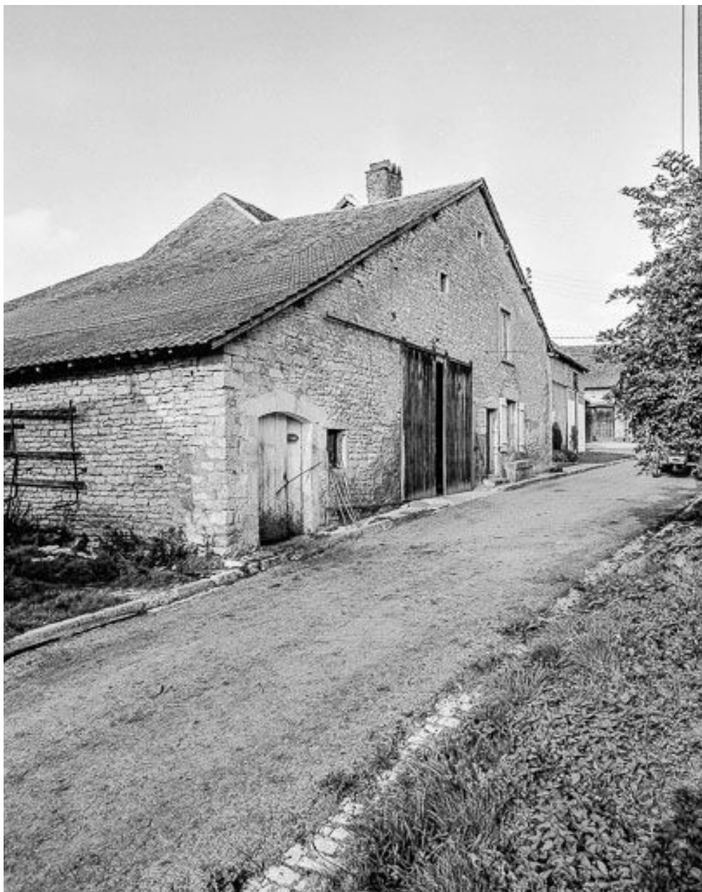
Façades antérieure et latérale gauche.
