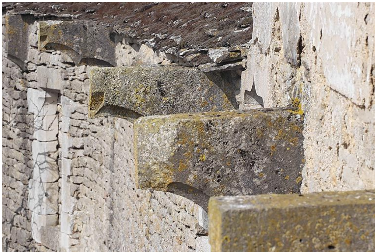
Les corbeaux soutenant le chemin de ronde.
