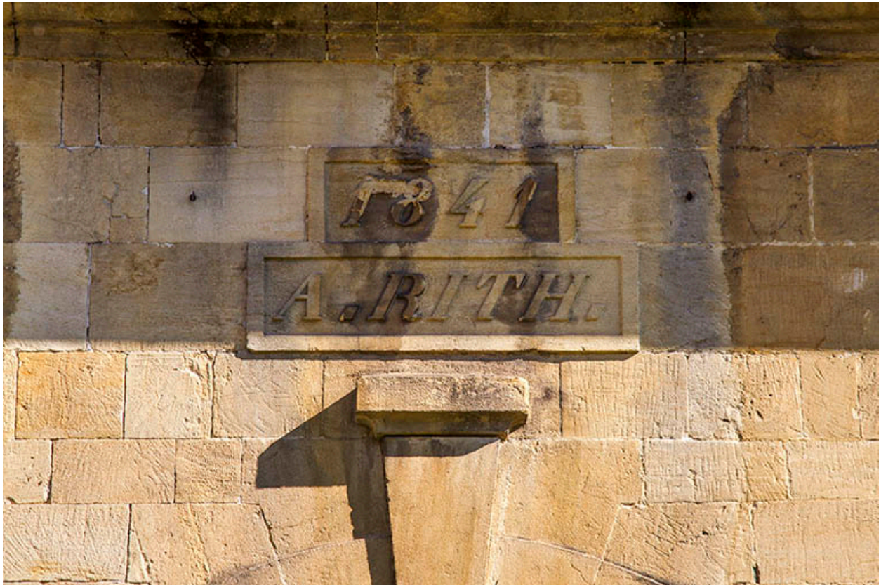
Corps sud, façade antérieure : date et inscription au-dessus de l'entrée de la grange.
