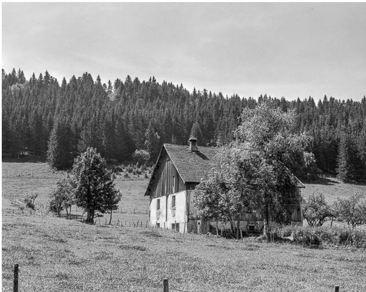
Façade latérale droite.
