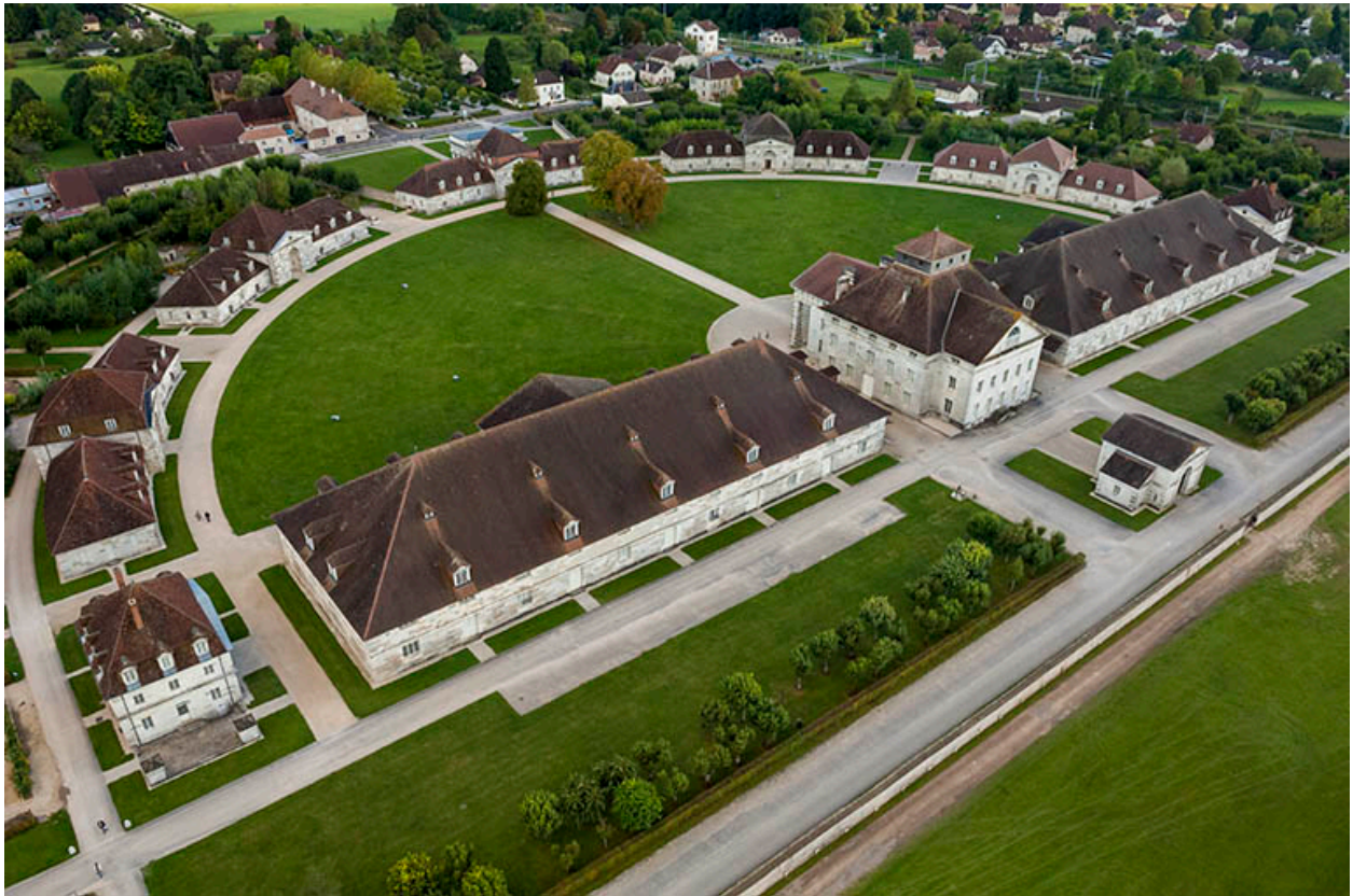
Saline d'Arc-et-Senans : vue aérienne depuis le sud.
