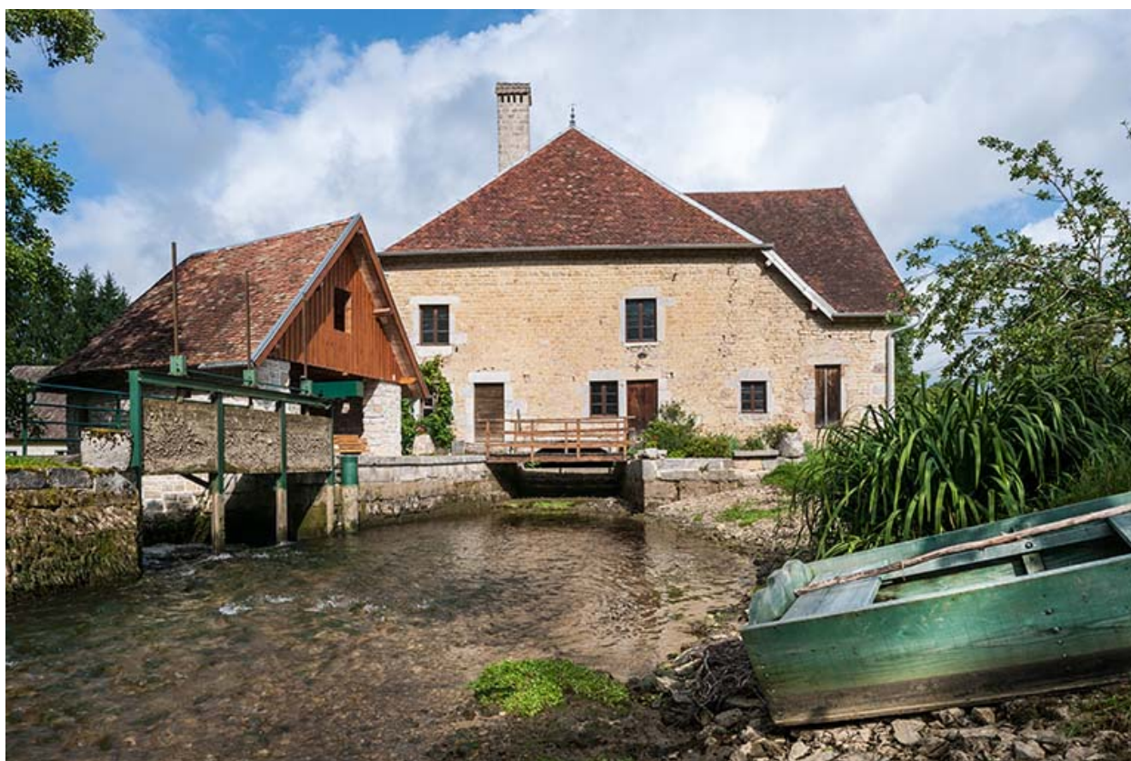
Vue rapprochée depuis le sud-est.
