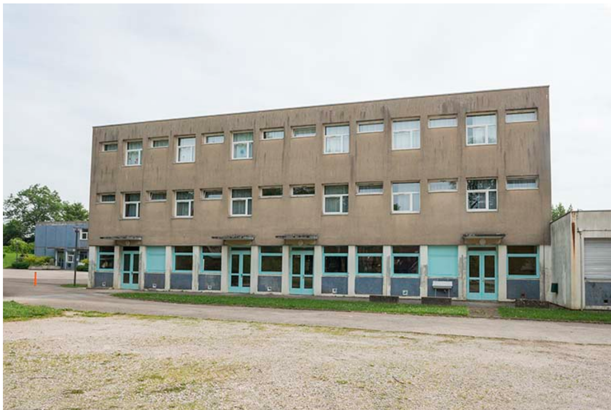
Façade sud-ouest de l'internat restauration.
