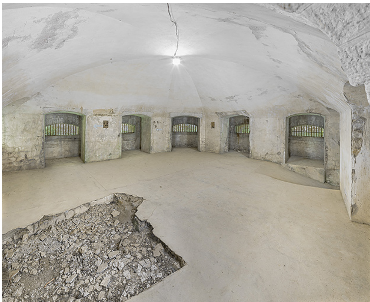
Vue intérieure de la double caponnière avec ses créneaux de tir.
