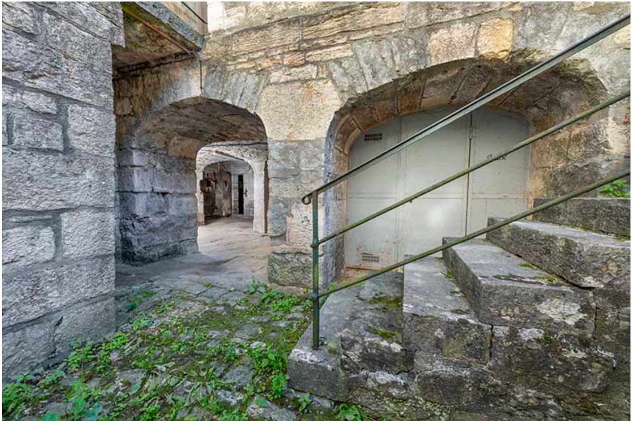
Cour ouest. Accès aux cellules de prison.
