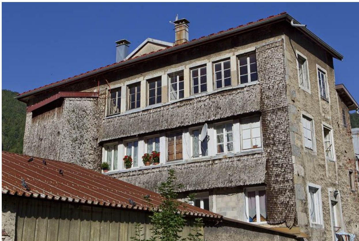
Façades postérieure et latérale droite.
