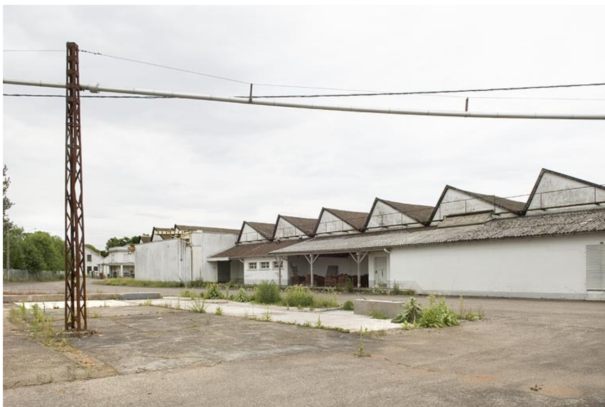
Atelier de fabrication depuis le sud-est.
