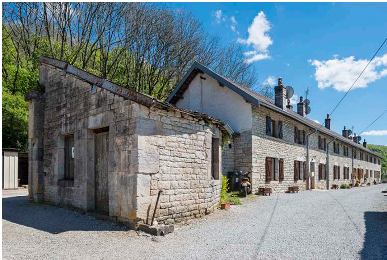
Logement ouvrier (aile sud).
