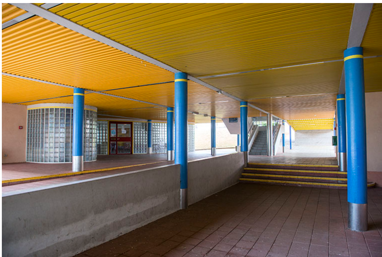
Vue intérieure de circulation abritée.
