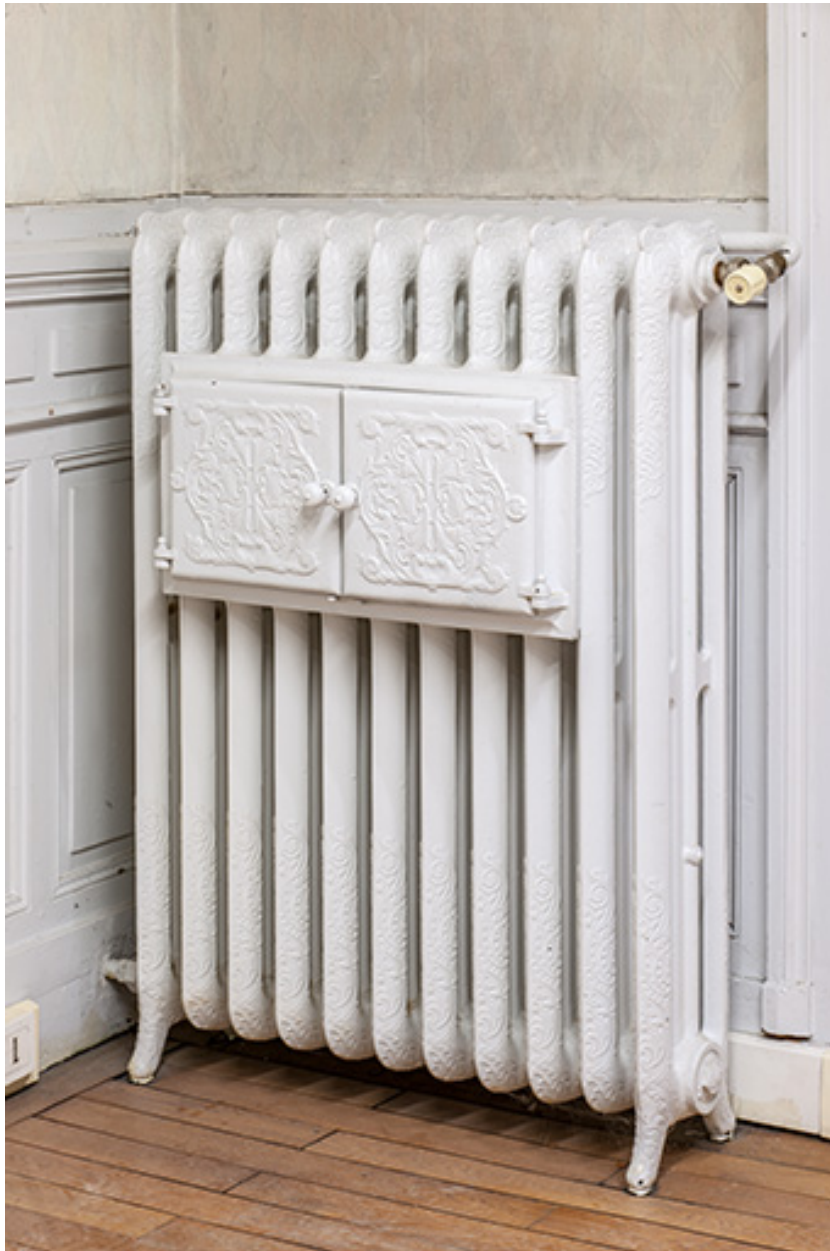
Bâtiment de l'administration, 1er étage : radiateur à chauffe-plat.
