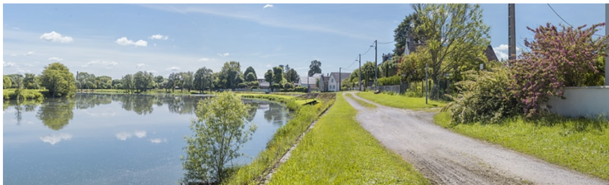
Vue d'ensemble de la digue, prise d'aval.
