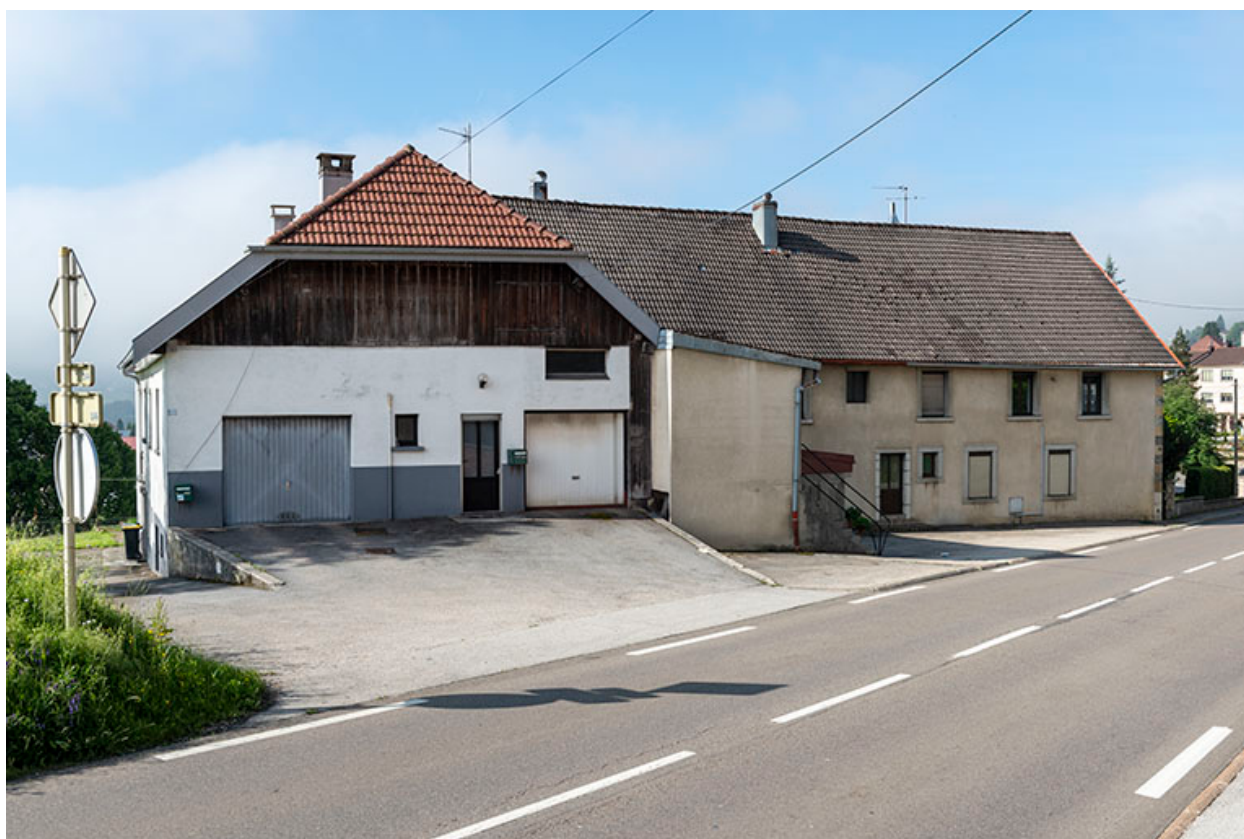
Ancien site : vue d'ensemble, depuis le nord.
