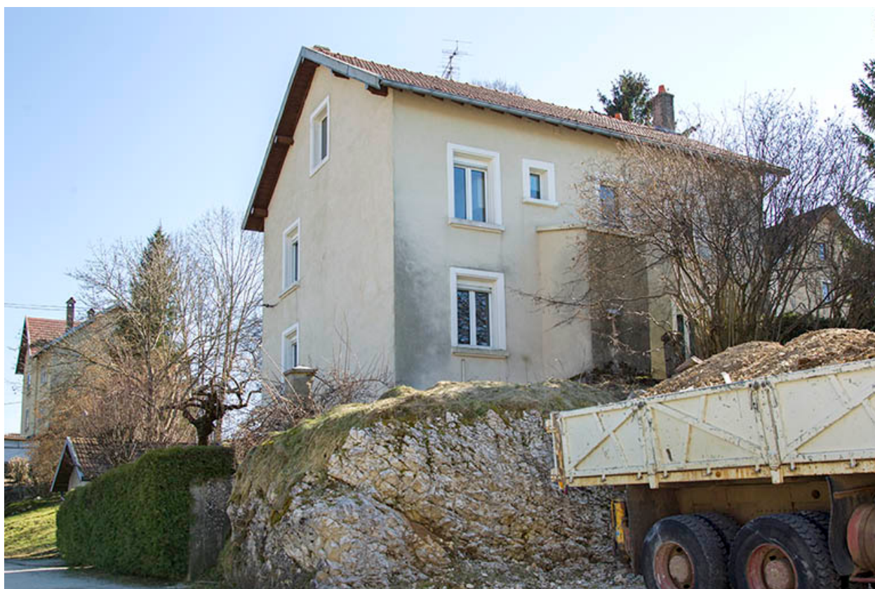
Façades postérieure et latérale droite.
